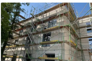
Hagen, Im Alten Holz: An den ersten beiden Gebäuden der insgesamt drei Gebäudekörper sind die Außenarbeiten nahezu abgeschlossen. Nun folgt der Innenausbau sowie der Start des zweiten Bauabschnitts.
