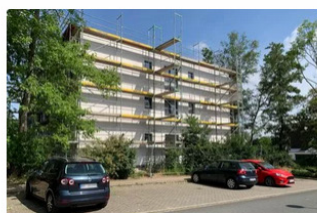
Hagen, Im Alten Holz: Seitenansicht des ersten Bauabschnitts.
