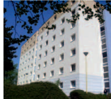
September 2007: Vier Jahre Umbaumaßnahmen
